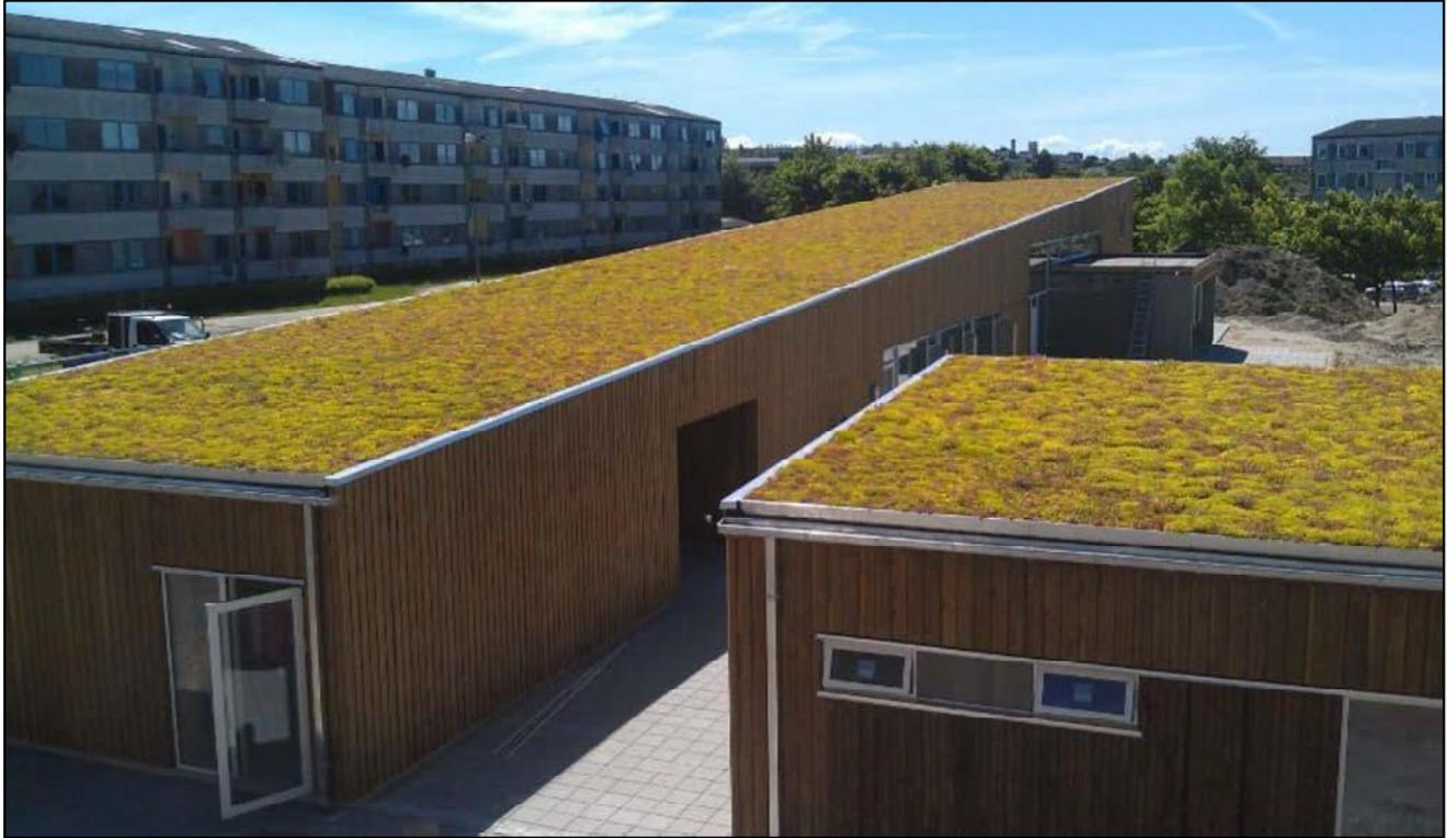
Figur 9. Exempel på sedumtak (Källa: Engman Tak AB)
