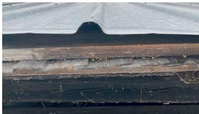
*Timrad ängslada placerad nere vid vattnet och tidigare brygga/pir. Under pannplåten finns äldre spåntäckning bevarad.*
